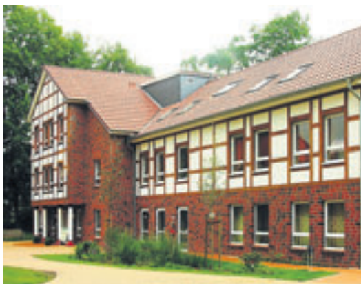
Das Team des Fachbetriebes hat für dieses neugebaute Altenheim in Hambergen sämtliche Elektroarbeiten durchgeführt. Foto: D'Behr
